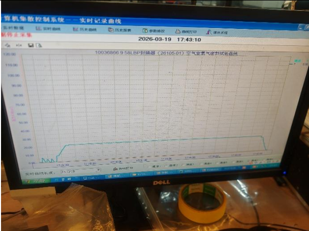
Pressure test 压力试验
